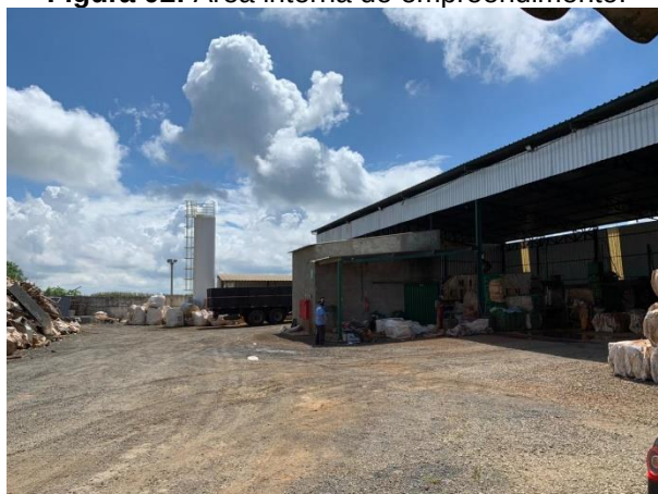
Figura 02: Área interna do empreendimento.
